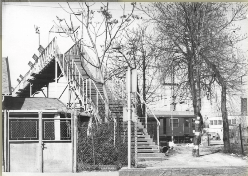
A vasúti felüljáró
